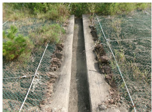
숏크리트, 점검계단 전경
