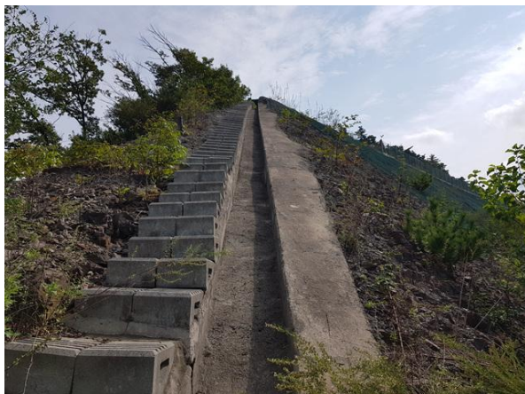
산마루측구, 점검계단 전경
